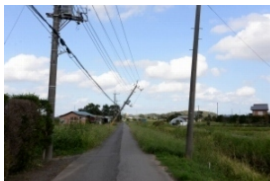
酒直ト杭地先の電柱倒壊
