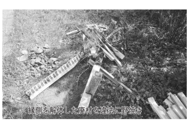
縁側を解体した廃材を違法に野焼き
