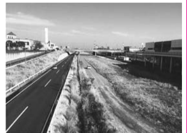
沿線北側の土地を利用します(千葉ニュータウン中央駅付近)
