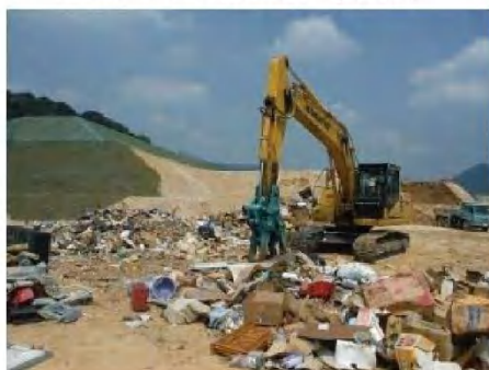
重機による粗分別 (②③)
