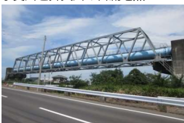
手賀川の水管橋
