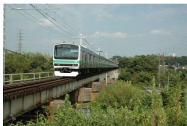
安食ト杭の鉄道橋
