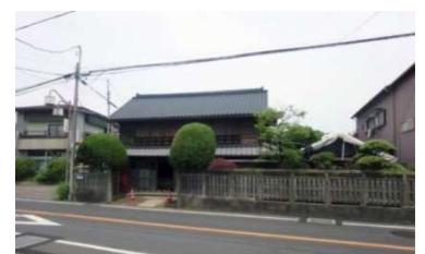
木下街道周辺の町家造りの建築物
