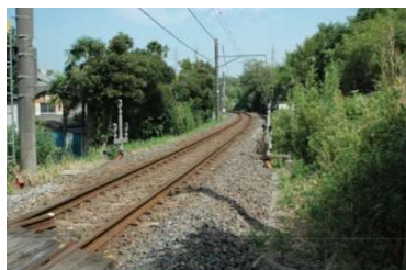
安食ト杭の鉄道敷
