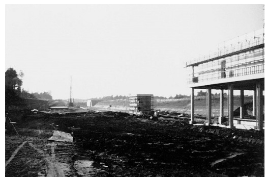
千葉ニュータウンの建設
