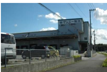
道路側に露出した駐車場
