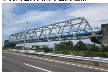
手賀川の水管橋
