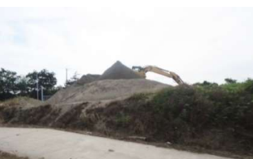
沿道側に露出している土石堆積場
