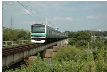
安食ト杭の鉄道橋
