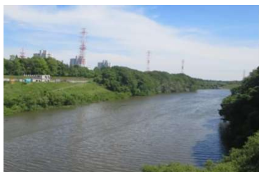
戸神川防災調節池
