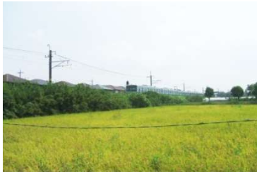
木下東の線に囲まれた鉄道敷
