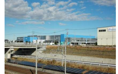
国道464号沿いの業務施設
