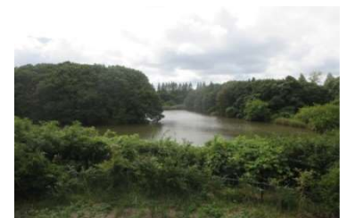
浦部川防災調節池
