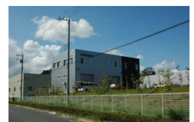
緑化された法面
