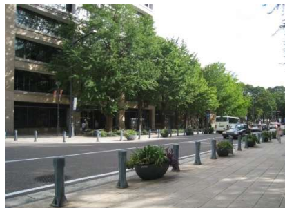
横浜市（安全・安心のもと車道沿いのプランターと防護柵）
