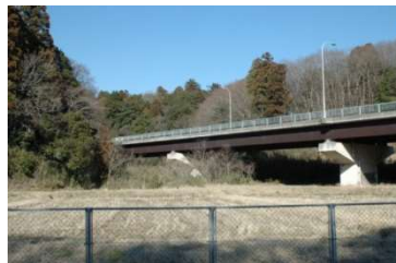
結縁寺の橋梁、桁が茶色系
