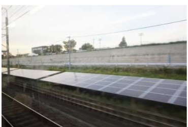
掘割部のメガソーラー
