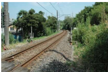
安食ト杭の鉄道敷
