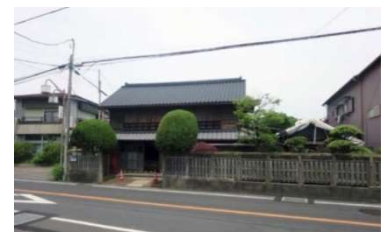
木下街道周辺の町家造りの建築物
