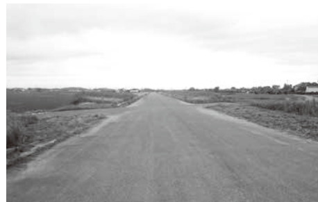
鎌ヶ谷本笠線バイパス整備中の道路
