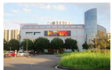
千葉ニュータウン中央駅南側の商業施設
