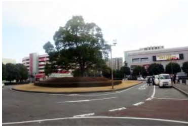
千葉ニュータウン中央駅南口駅前広場
