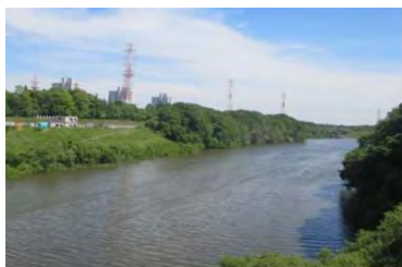
戸神川防災調節池
