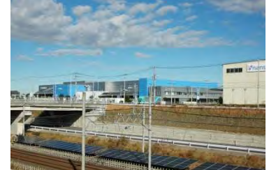
国道464号沿いの業務施設
