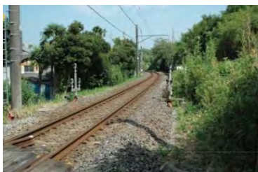
安食ト杭の鉄道敷
