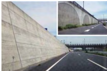
長大なコンクリート擁壁と半円形の模様が施された擁壁
