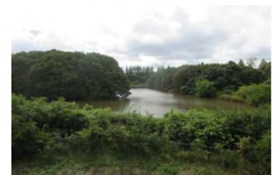
浦部川防災調節池
