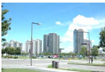
千葉ニュータウン中央駅北側の住宅
