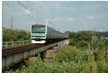
安食ト杭の鉄道橋
