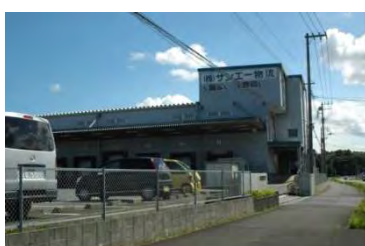
道路側に露出した駐車場
