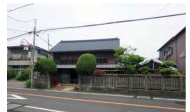
木下街道周辺の町家造りの建築物
