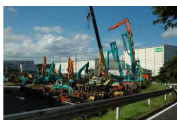
道路側に露出した重機類
