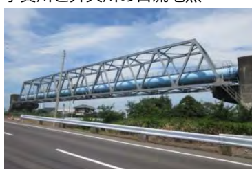
手賀川の水管橋
