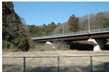
結縁寺の橋梁、桁が茶色系
