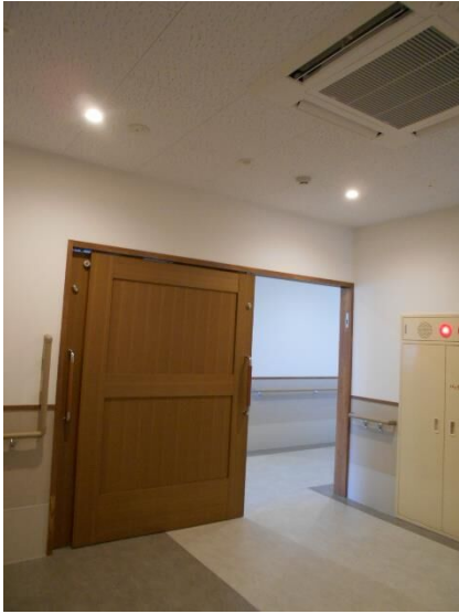
ホール（ユニット出入口）
