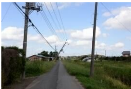
酒直ト杭地先の電柱倒壊
