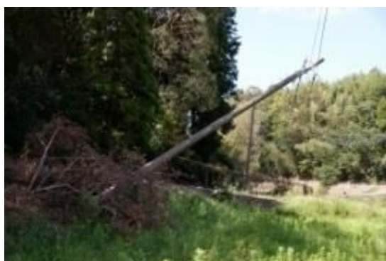
松崎地先の電柱倒壊
