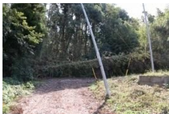
山田地先の電柱倒壊
