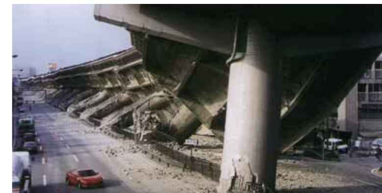
倒壊した阪神高速道路
