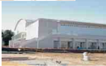
▶3月に完成を控える「印西市総合体育館」の外観
