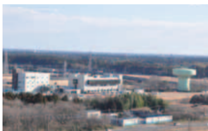
▲特徴的な調圧水槽(右側の薄緑色の塔)が目印の「北総浄水場」
