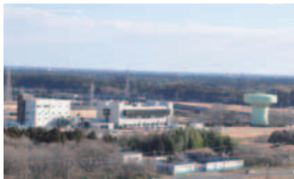
▲特徴的な調圧水槽（右側の薄緑色の塔）が目印の「北総浄水場」
