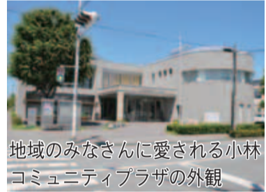
地域のみなさんに愛される小林コミュニティプラザの外観
