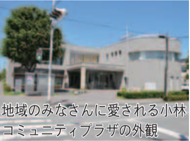
地域のみなさんに愛される小林コミュニティプラザの外観
