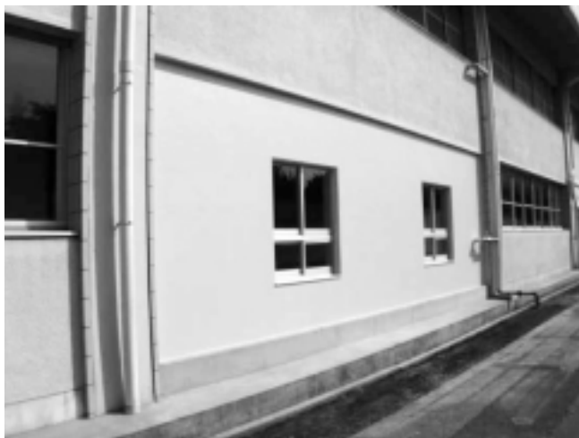
完成した六合小学校特別教室棟
