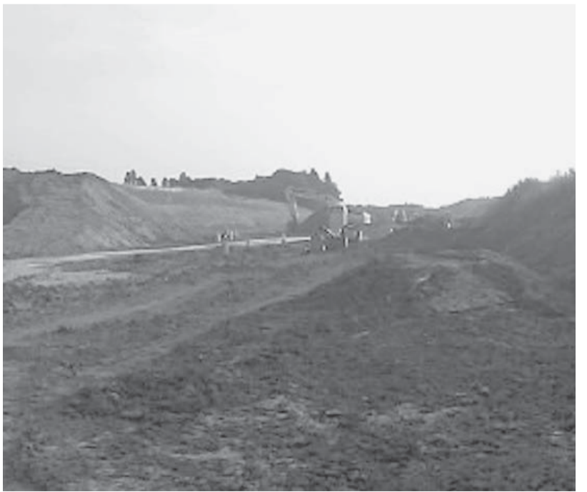
整備が進む千葉ニュータウン8住区(鹿黒地先)
