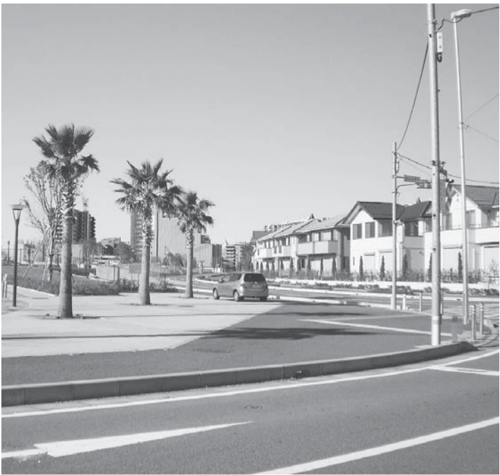
戸建住宅の建設が進む東の原
