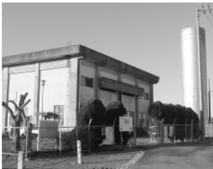
建替が予定されている宗吾北揚排水機場
