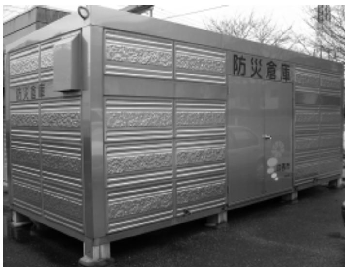
災害に備え、食料や医薬品等が備蓄されている防災倉庫
