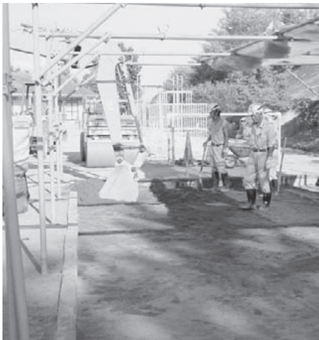
除染作業が進む教育施設
