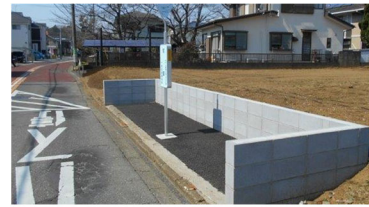
地権者から用地を借用し、バス待ちスペースを確保した事例
