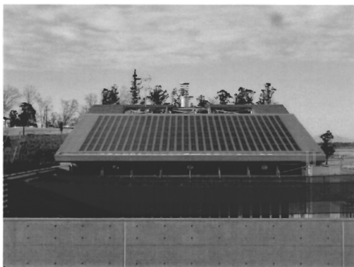
総合体育館屋上の太陽光発電パネル (発電容量 12.6 kW)
