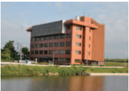
▲中央公民館の外観。朝日に映えるレンガ色の外壁が目印です
