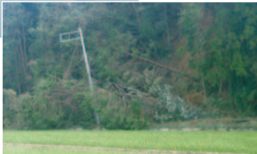
▶山田地先で発生した土砂災害
