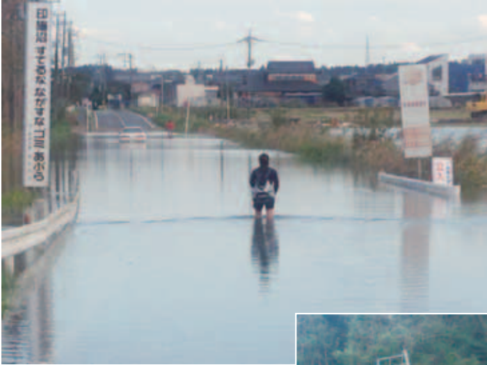
▲中央排水路(平賀)の浸水被害様子(写真正面が酒々井町)
