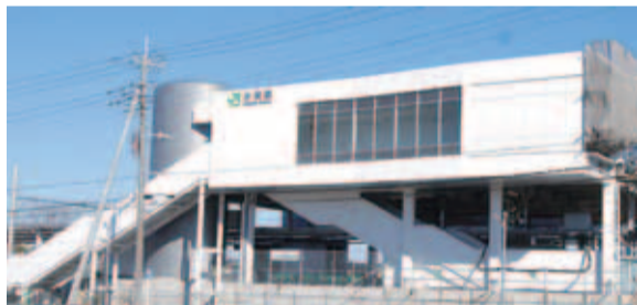
改修工事が進む新駅舎(写真は南口)
