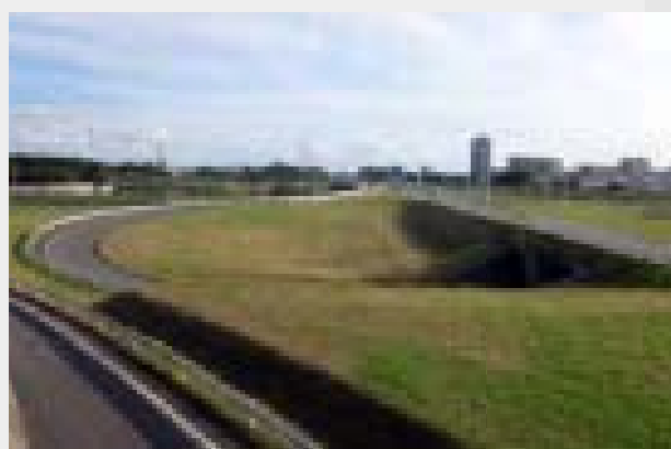
▲国道 464 号と主要地方道船橋・印西線のジャンクション
