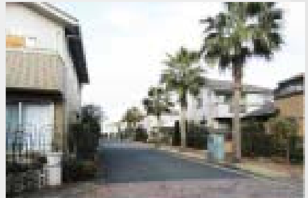
▲東の原地区の無電柱化された住宅地
