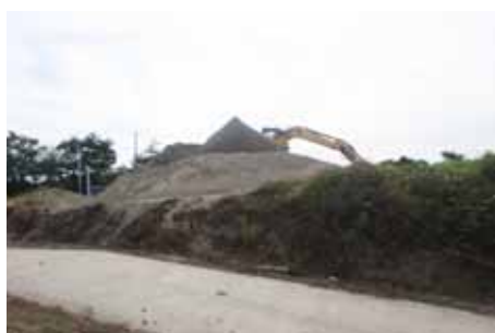
沿道に露出した土石堆積場
