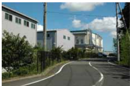
敷地外周部の低中木による緑化
