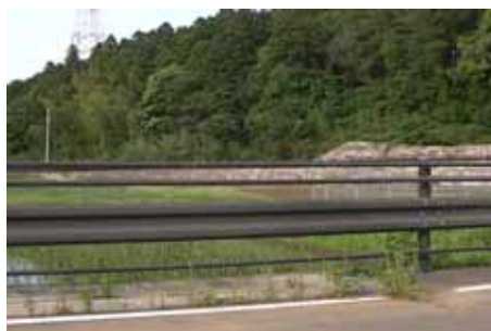
周辺の緑に配慮した色彩のガードレール
