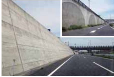
国道464 号の無機質な擁壁と化粧を施した擁壁
