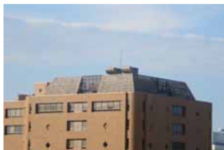
ルーバーにより屋上設備機器類が露出しないように遮蔽
