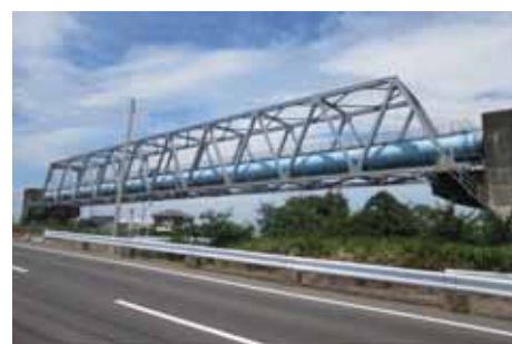
手賀川の水管橋
