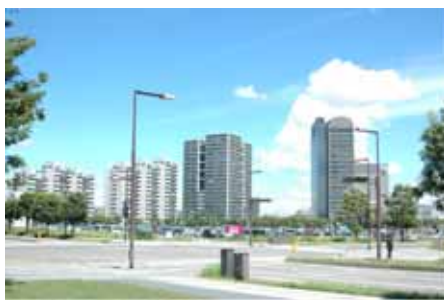
千葉ニュータウン中央駅北側の集合住宅
