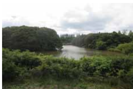
浦部川防災調節池
