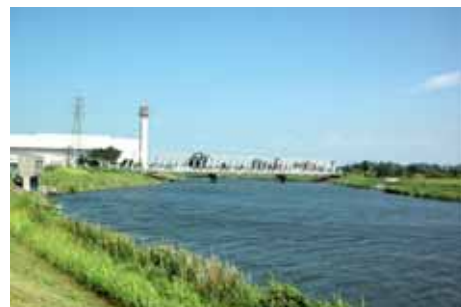
発作の手賀川を渡る橋梁
