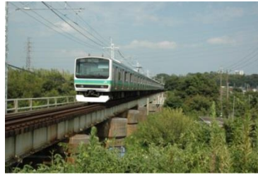
安食ト杭の鉄道橋
