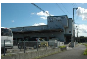
道路側に露出した駐車場
