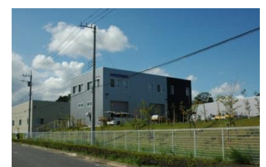
緑化された法面
