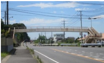
大森の歩道橋
