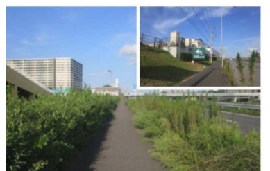
歩道脇の雑草と道路側に露出した設備機器類
