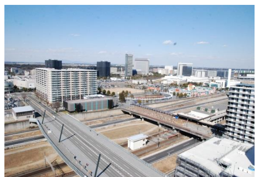
千葉ニュータウンの建設
