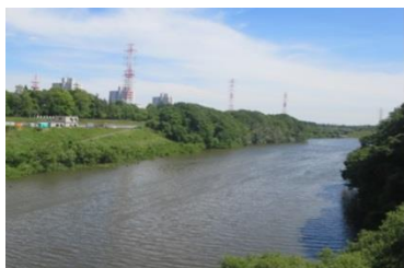
戸神川防災調節池
