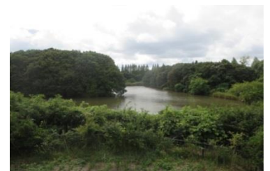
浦部川防災調節池
