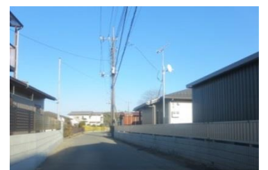
道路沿いのブロック塀
