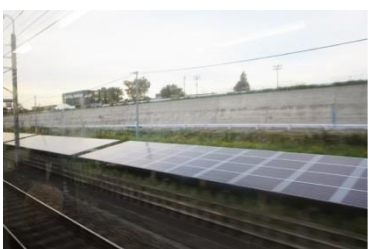
掘割部のメガソーラー
