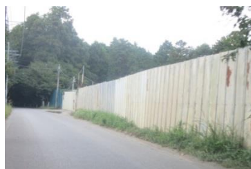
障壁で囲われた資材置場(ヤード)
