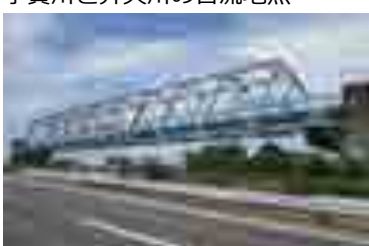
手賀川の水管橋
