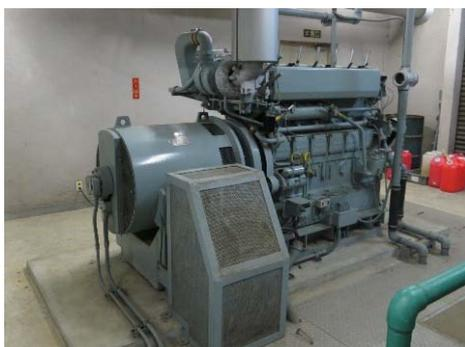
図 3-4. 自家発電設備 (平岡配水場設置 1980 年製造)
