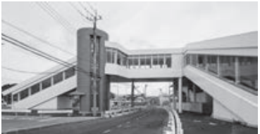
▶市道18-045号線(小林駅南口駅前広場など)整備事業(31,428万円)
