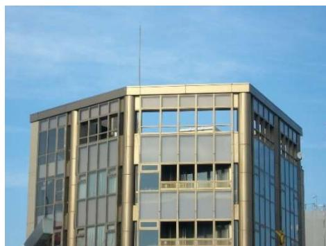
外壁を最上部にまで立ち上げ、屋上設備を遮蔽するだけでなく、一体的にデザインしている。
