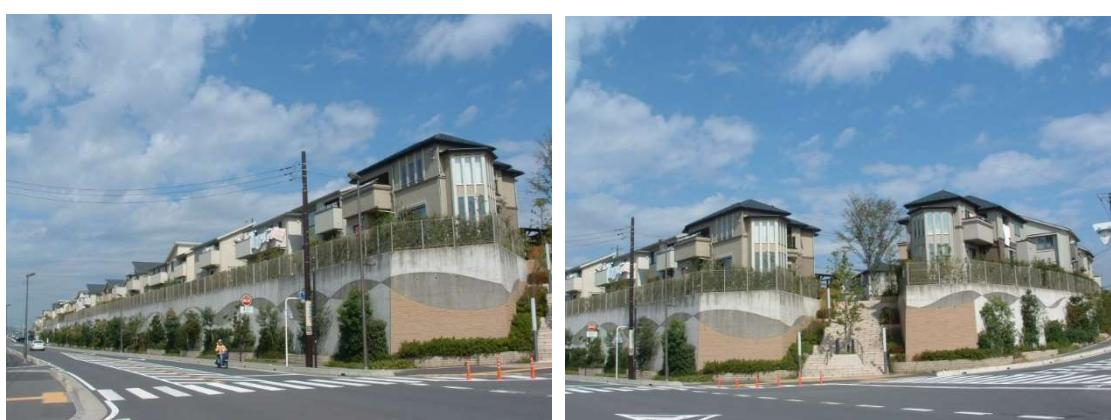
擁壁の前面に植栽スペースを確保し、圧迫感を軽減するとともに、交差点部分にアクセス路を設け、まちに開かれた印象を与えている。
