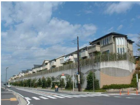
擁壁の前面に植栽スペースを確保し、圧迫感を軽減するとともに、交差点部分にアクセス路を設け、まちに開かれた印象を与えている。
