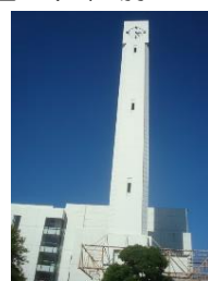
高さ59mの煙突
