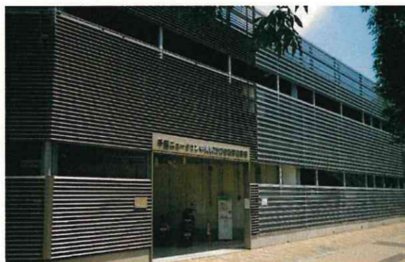
千葉ニュータウン中央駅南口自転車駐車場
