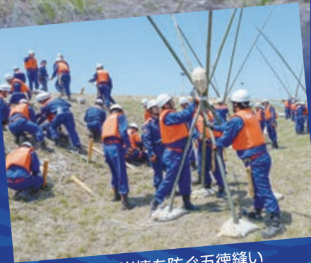
堤防の崩壊を防ぐ五徳縫い
