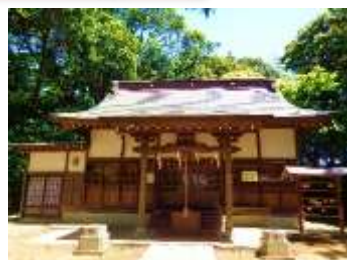
拝殿前の鳥居の土台2基
