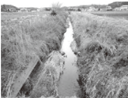
河川改修が必要な飛里橋落とし
