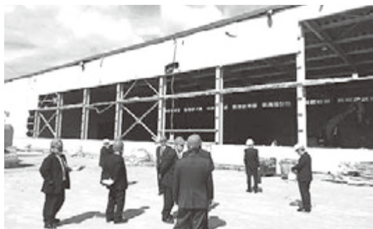
(株)日本デキシー工場跡地の現地視察
