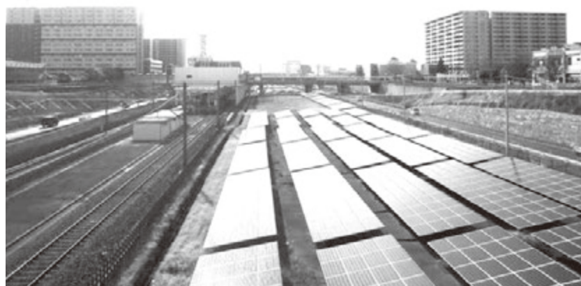
464号掘割部のソーラーパネル
