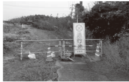
令和3年度によくやく改修される下井3号橋
