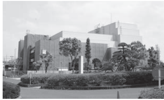
文化ホールの大規模改修工事
