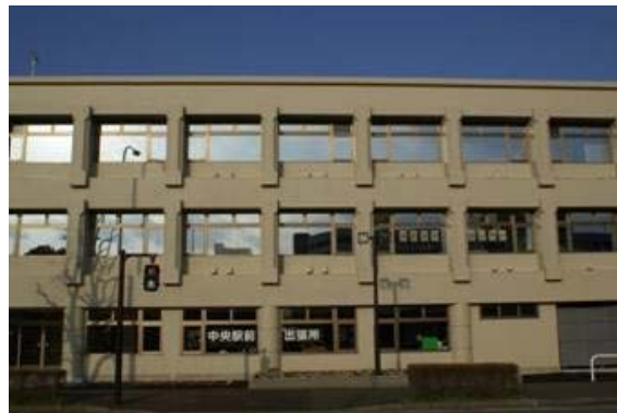
図4 中央駅前地域交流館2号館
