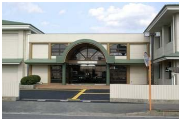
図3 中央駅前地域交流館1号館
