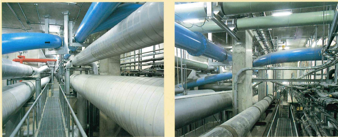
■ 共同溝の内部
