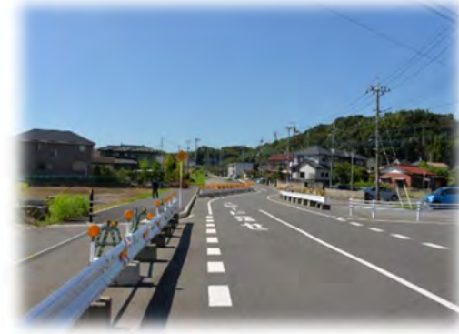
都市幹線道路である都市計画道路 3・4・11号小林駅南口線 （一般県道印西印旛線バイパス）
