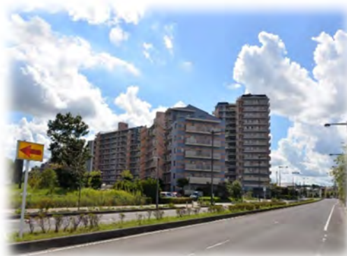
都市幹線道路である市道 長作台・遠蓮線 (2201)
