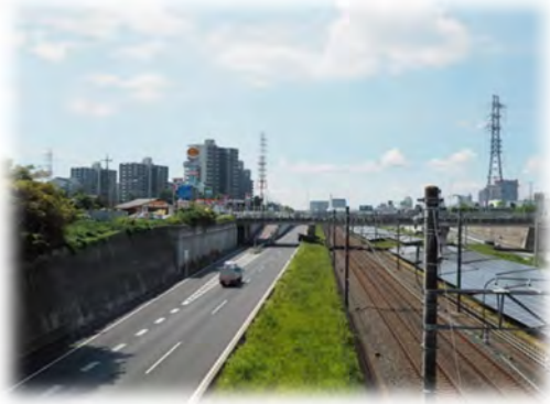
主要幹線道路である国道 464 号（北千葉道路）
