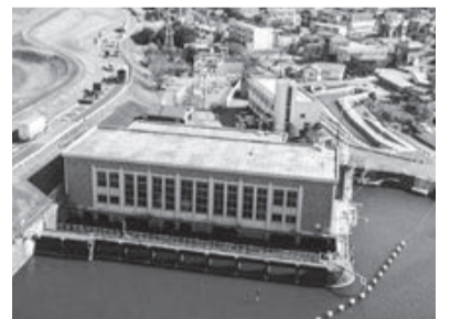
昭和31年に建設された手賀排水機場
