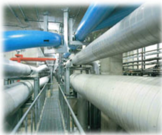
共同溝の内部
