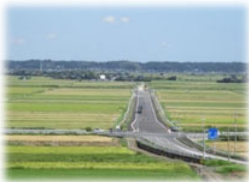
都市幹線道路である主要地方道 鎌ヶ谷本埜線バイパス
