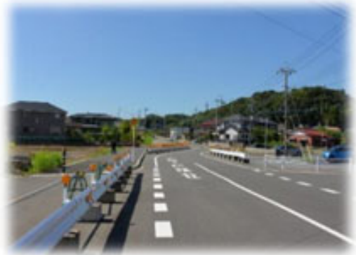
都市幹線道路である都市計画道路 3・4・11号小林駅南口線 （一般県道印西印旛線バイパス）
