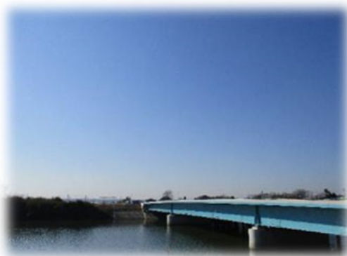
整備を促進する 主要地方道鎌ヶ谷本埜線バイパス
