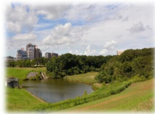
松虫川防災調節池 （ウシムグリの池）
