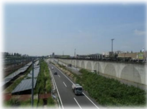
国道 464 号（北千葉道路）
