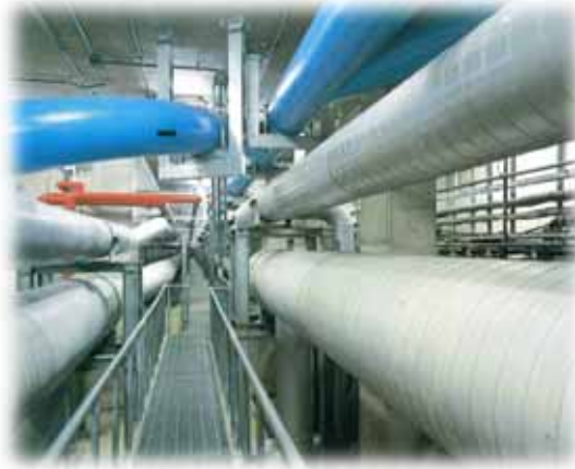
共同溝の内部
